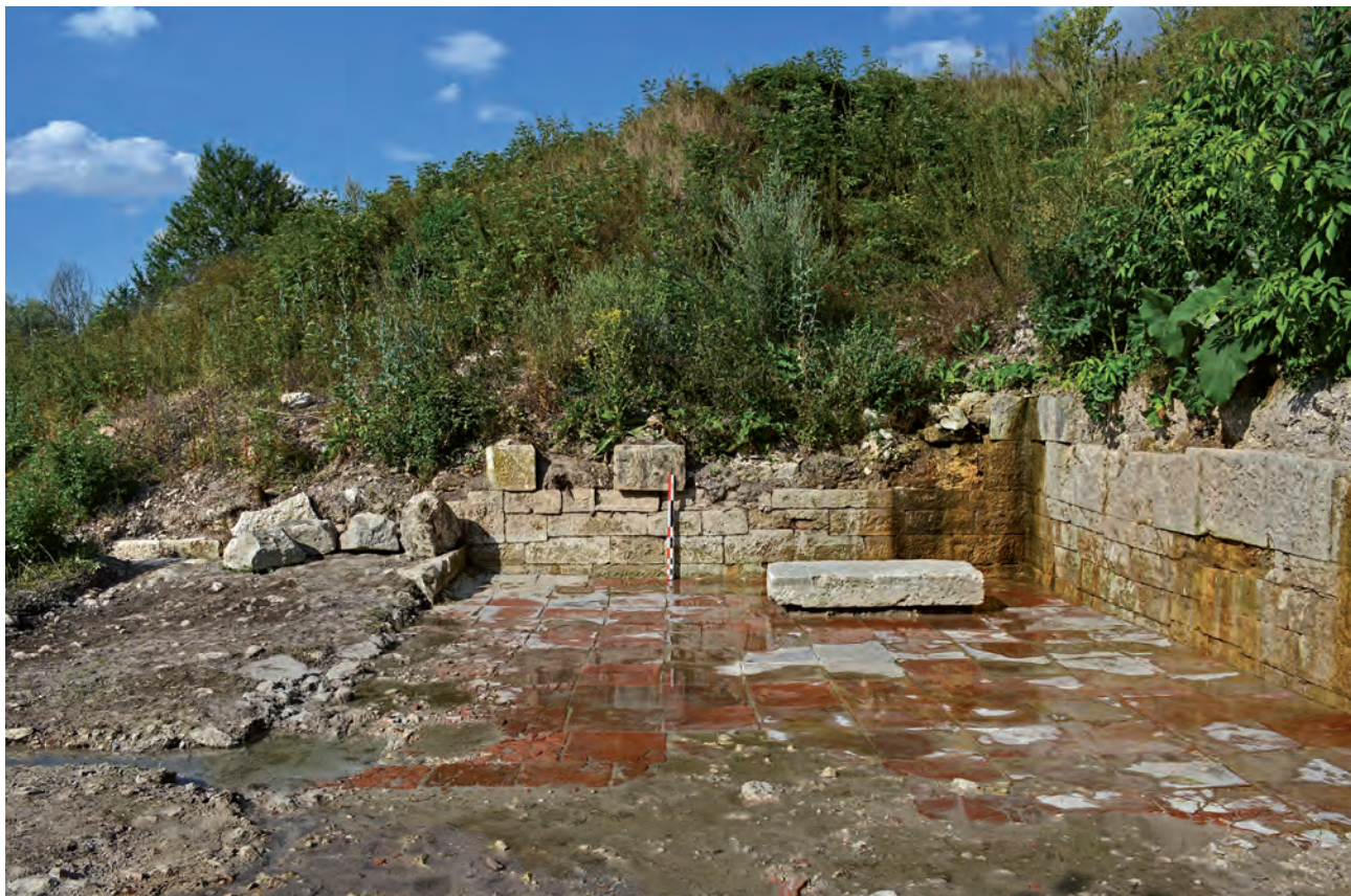
Fig. 8. The cistern in 2016, looking north (N. Beaudry).
